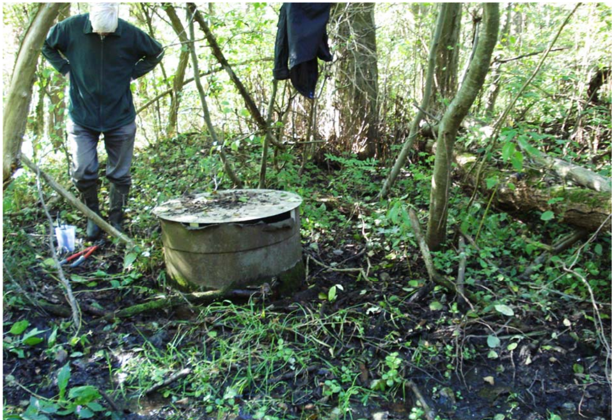
Abbildung 30: Schachtbrunnen im Merklinger Ried
